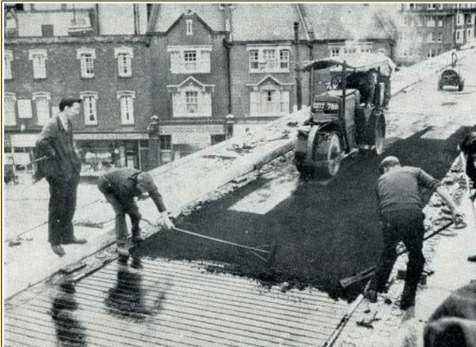
1969, Verlegung von Asphalt auf der oberen Fahrbahn einer Hammerschmidt-Kreuzung in London ( Elektrische Beheizung der Fahrbahnen, von Robert Félix, 1971, Ultimheat Museum* )
